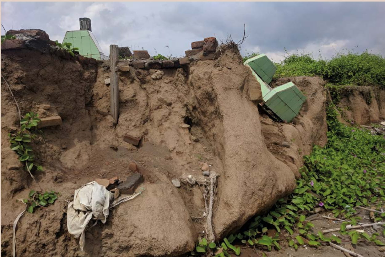
Os danos causados ao cemitério ao longo da costa de Takalar devido ao aumento da erosão costeira após a dragagem feita pela Boskalis. Crédito da foto: Both ENDS, 2019.
